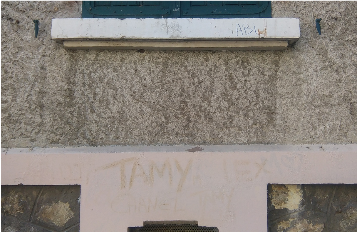
3 e cour, bâtiment 3, rue Suzanne Dubuisson
