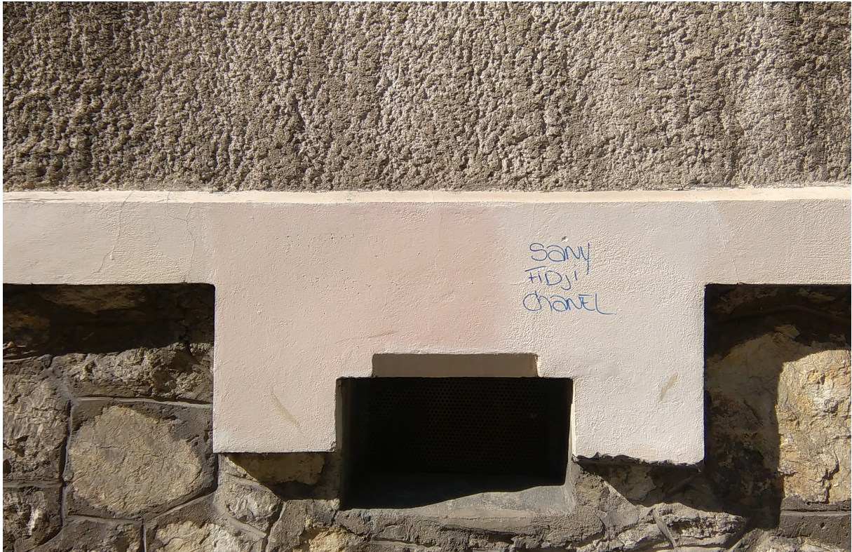
1 ère cour, bâtiment 1, rue Duguesclin
