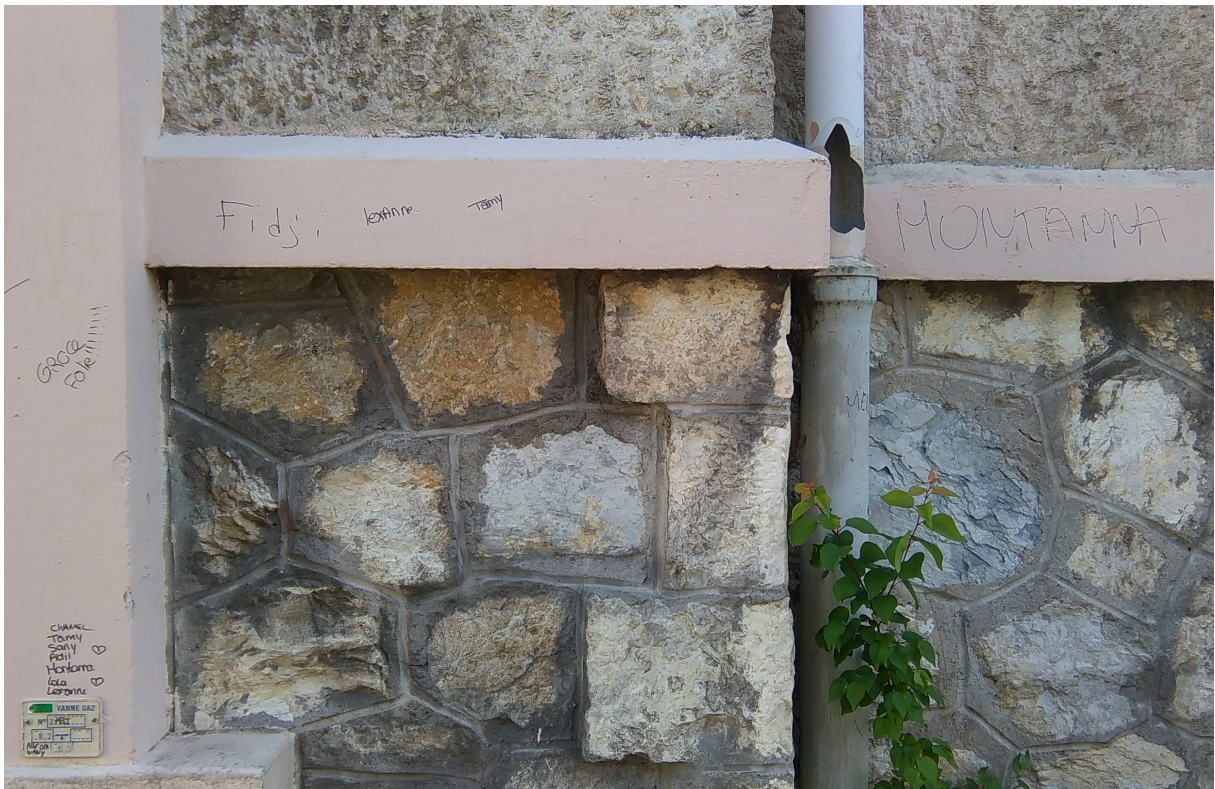
3 e cour, bâtiment 3, rue Suzanne Dubuisson
