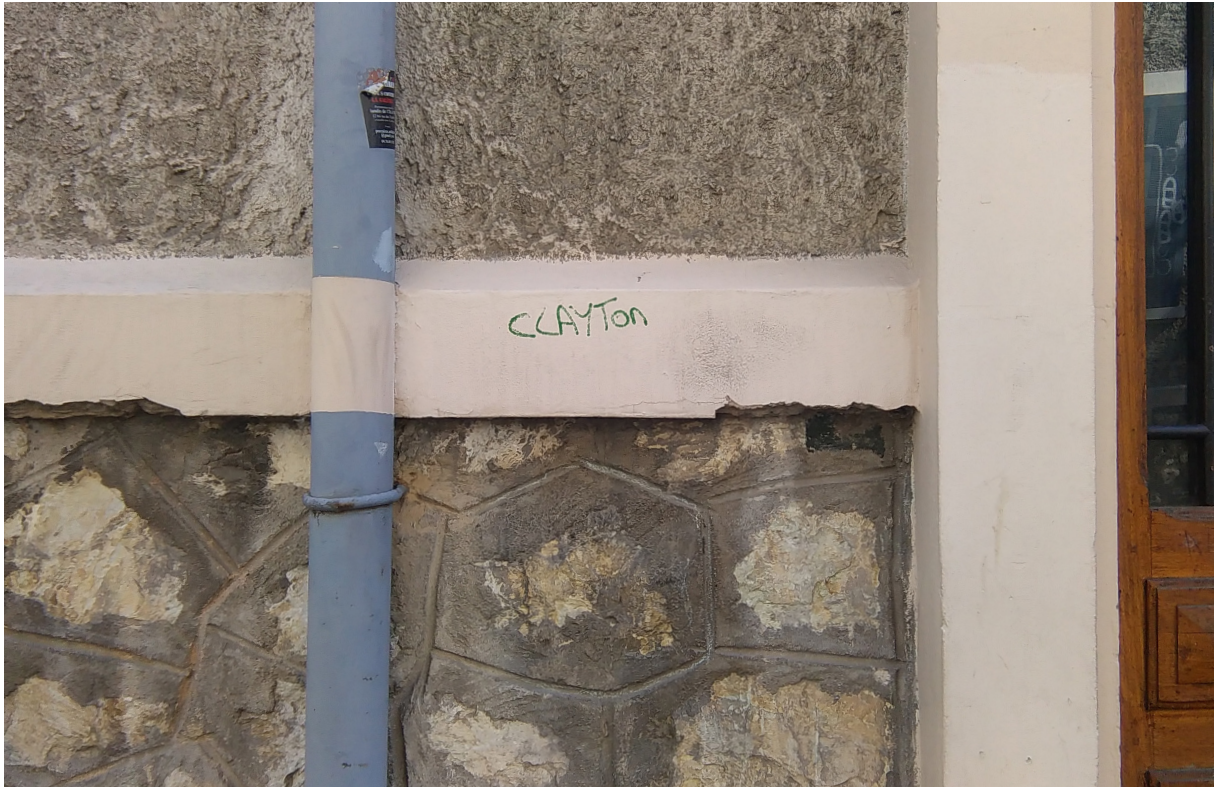
2 e cour, bâtiment 6, place André Charpin
