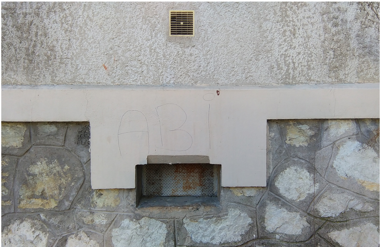
1 ère cour, bâtiment en U, rue René Cassin
