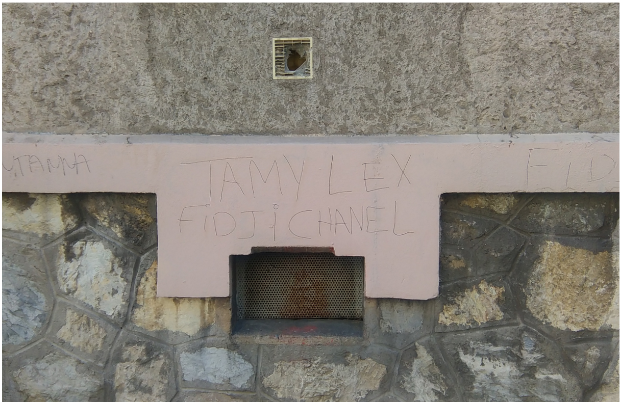
3 e cour, bâtiment 3, rue Suzanne Dubuisson
