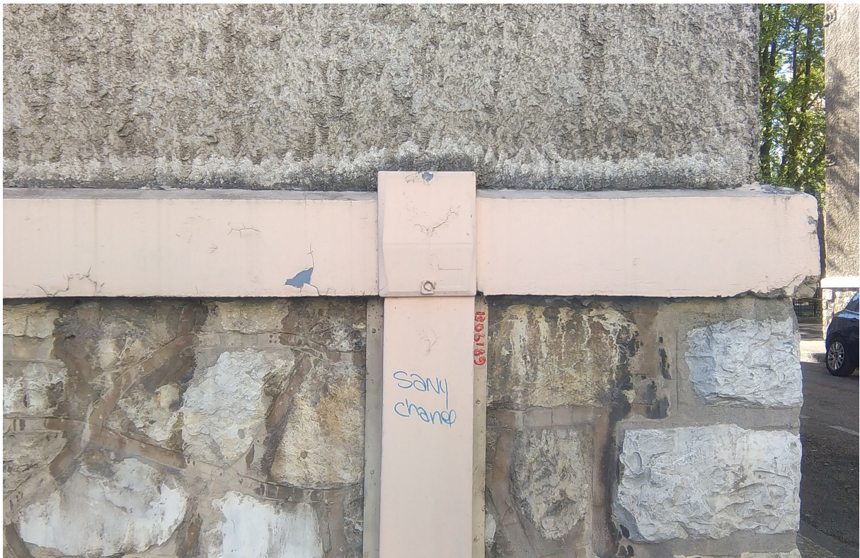
2 e cour, bâtiment 1, rue René Cassin
