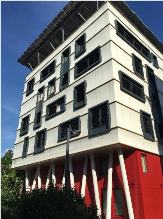
Figure 25 : Bâtiment à énergie positive – ZAC de Bonne Source : A. Piedevache
