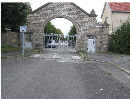
Figure 40 : Porche – Caserne de Lorette Source : Ville de Saint-Malo
