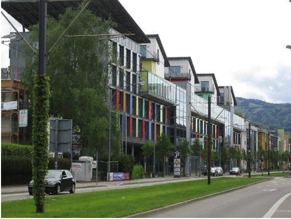
Figure 10 : Bâtiments à panneaux solaires - Ecoquartier Vauban Source : www.vauban.de © Andreas Delleske
