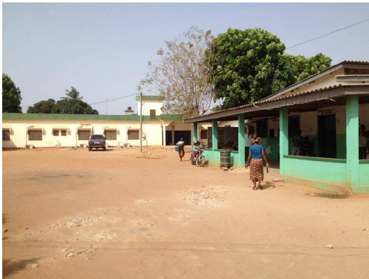
Figure 36 : Photographie des bâtiments du CMS d'Adidogomé
