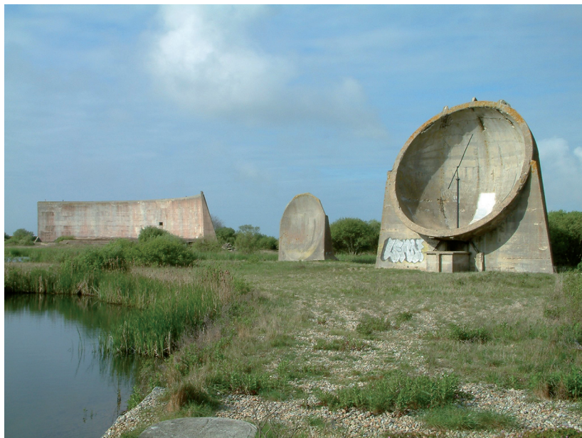
Fig. 31. Miroirs sonores construits pendant la seconde guerre mondiale à Denge, Angleterre. Le grand mur courbe fait 60m de long, les paraboles font 7m et 10m de large. Auteur inconnu.
