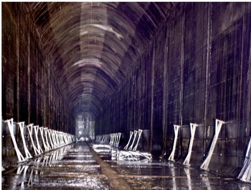
Fig. 99. Réservoir à carburant en Écosse. Record du monde du temps de réverbération le plus long : 112 secondes.
