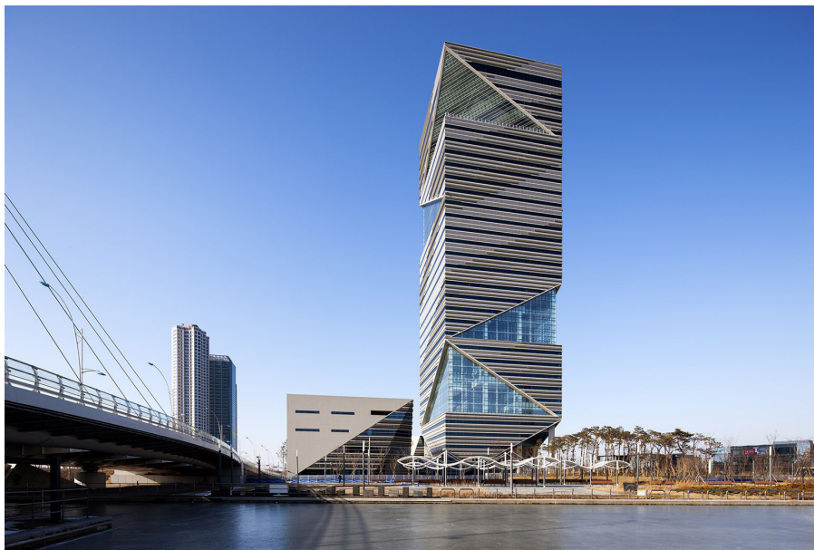
La G Tower, siège du centre de contrôle de Songdo.
