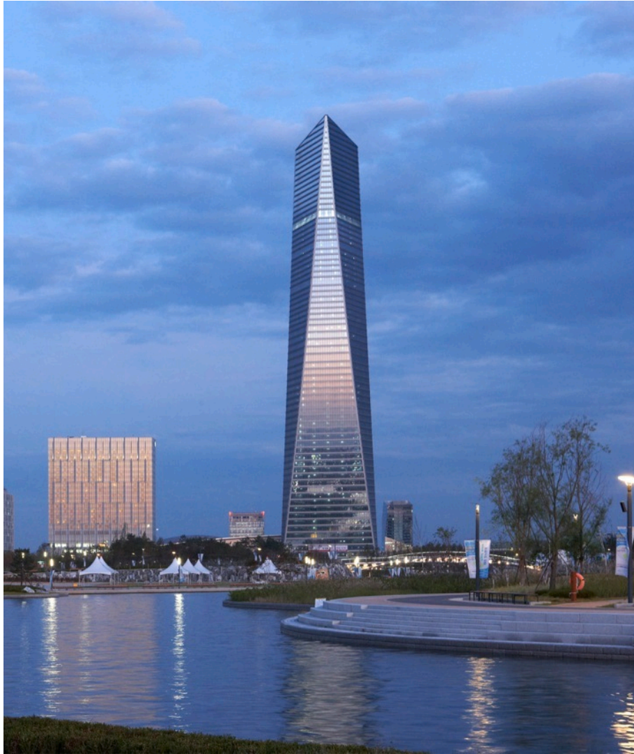
La North-East Trade Tower (NEATT), la plus haute tour de Songdo surplombant la ville de ces 305 mètres et reprenant les lignes du One World Trade Center de Manhattan.
