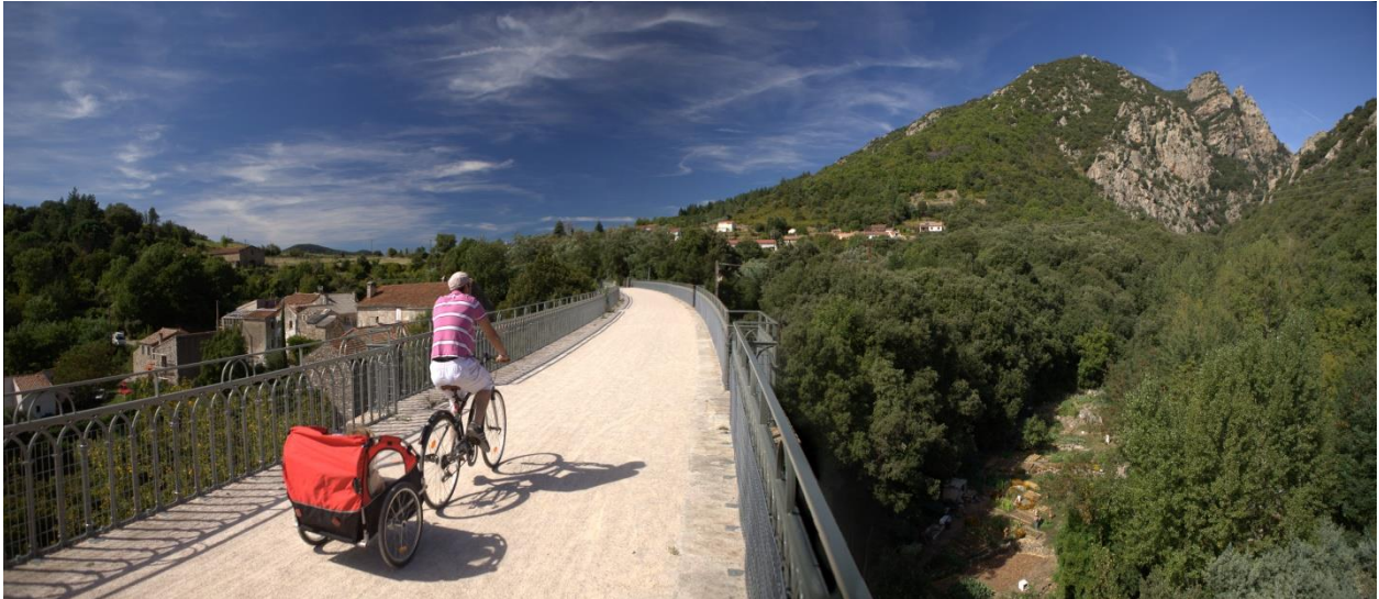
Photo 1 : Voie Verte Passa Païs au niveau de Mons la Trivalle (source : PNRHL, 2014)
