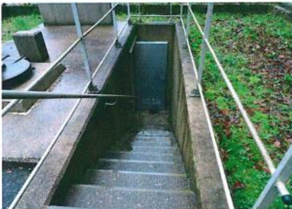
Escalier d'accès vers la chambre de captage
