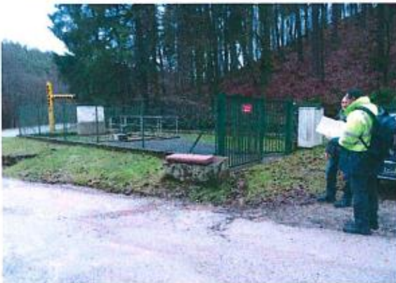
Vue extérieur du PPI
