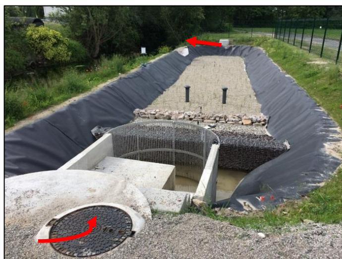
Vue du filtre planté de roseaux dans son ensemble. On distingue le regard de répartition, le dégrilleur, le massif, le trop-plein et le regard de sortie (la vanne de régulation du débit de sortie a été installée a posteriori) (29/10/2015)
