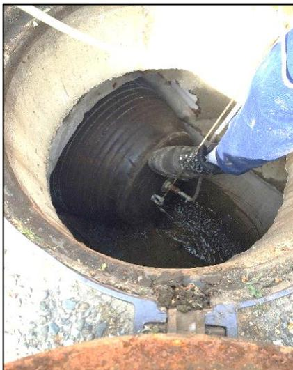
L'obturateur principal est ensuite retiré pour réaliser un effet de chasse similaire à la réaction du réseau face à un événement pluvieux.
