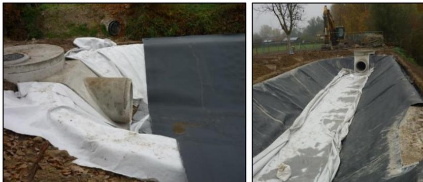
Géotextile anti-poinçonnement (en blanc) et géomembrane d'étanchéité (en noir)
