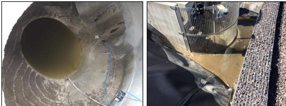
Figure 3-6 : Zones de dépôts dans le regard de répartition (gauche) et en amont des gabions (droite) (29/04/2016)
