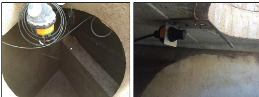
Figure 2-7 : Enregistreur-transmetteur de données (gauche) et sonde à ultrason (droite) installés dans le déversoir d'orage 8001 (22/02/16)
