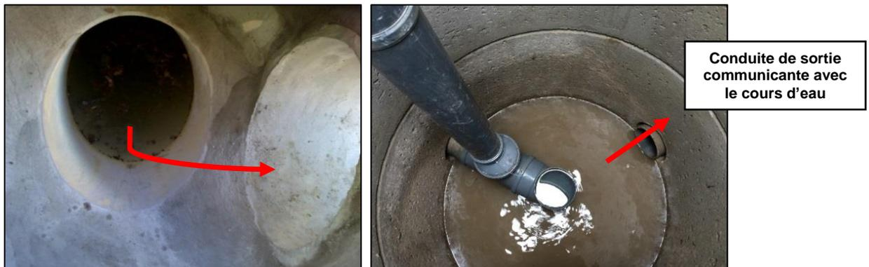
Vue de la conduite d'arrivée du siphon dans le regard de répartition, le départ vers le filtre est situé à droite ; système de maintien du niveau d'eau dans le filtre et tube permettant une mesure de niveau, situé dans le regard de sortie (29/10/2015)
