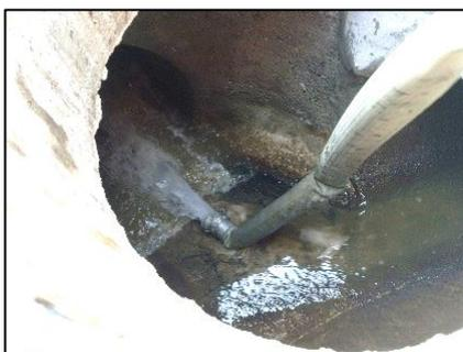
On remarque également une chute d'environ 50 cm dans le regard où se trouvait l'obturateur principal. Elle permet de passer d'une conduite 700 à 1000 mm. Le niveau d'eau est pratiquement au niveau du haut de la chute qui est imposé par la hauteur de crête du déversoir d'orage (46 cm).
