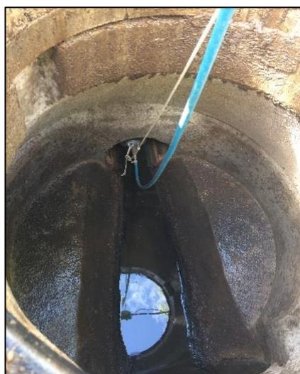
Avant chaque déversement artificiel, un second obturateur est placé à l'aval de la conduite étranglée du déversoir d'orage. L'objectif de cet obturateur est d'optimiser le déversement vers l'ouvrage de traitement.
