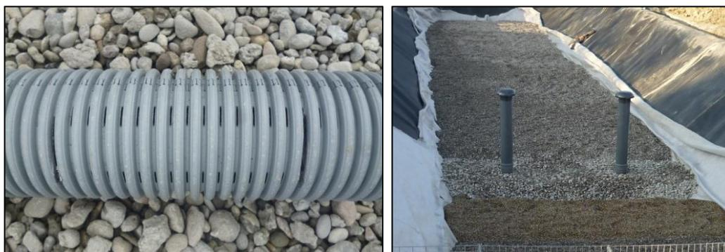
Photographies du drain et des cheminées d'aération en diamètre 150 mm (12/11/2015)
