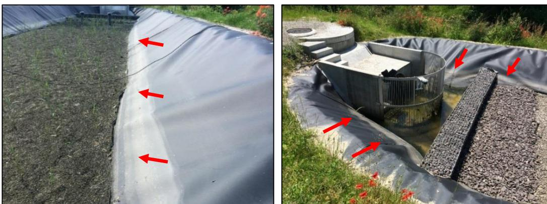
Figure 4-1 : Sollicitation de la géomembrane sur les parois latérales (24/06/2016)
