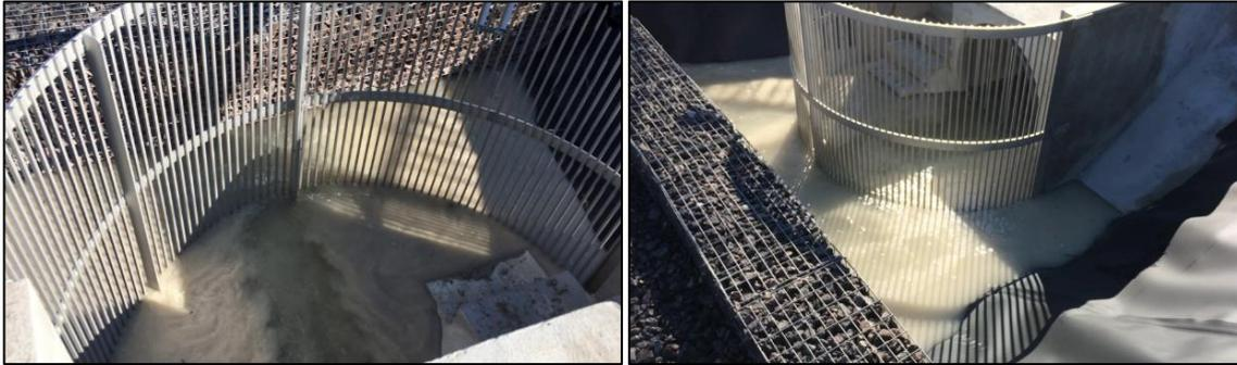
Figure 3-5 : Zone de dissipation du flux hydraulique (29/04/2016)
