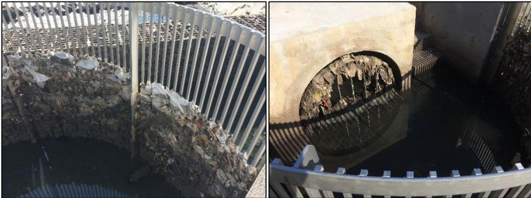
Figure 3-11 : Lingettes retenues par le dégrilleur (gauche) et la grille anti-intrusion (droite) suite à de nombreux déversements (24/06/2016)
