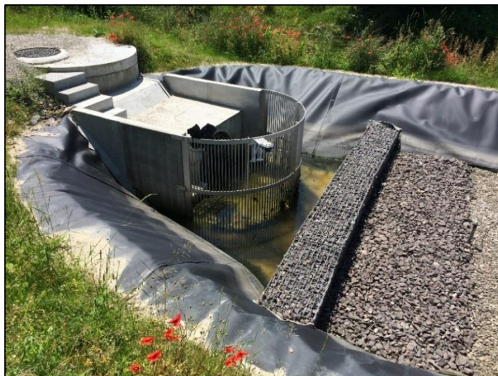
Effet de vases communicants entre l'ouvrage et le milieu naturel (24/06/2016)
