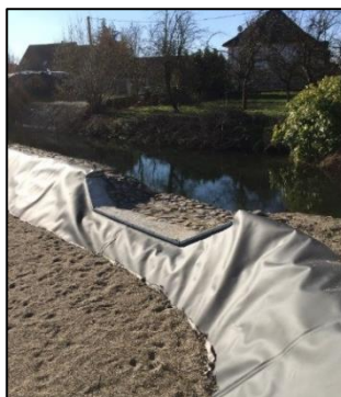
Photographie du trop-plein situé à l'extrémité de l'ouvrage (12/02/2016)
