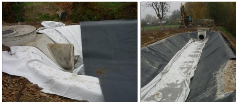
Géotextile anti-poinçonnement (en blanc) et géomembrane d'étanchéité (en noir) (02/11/2015)
