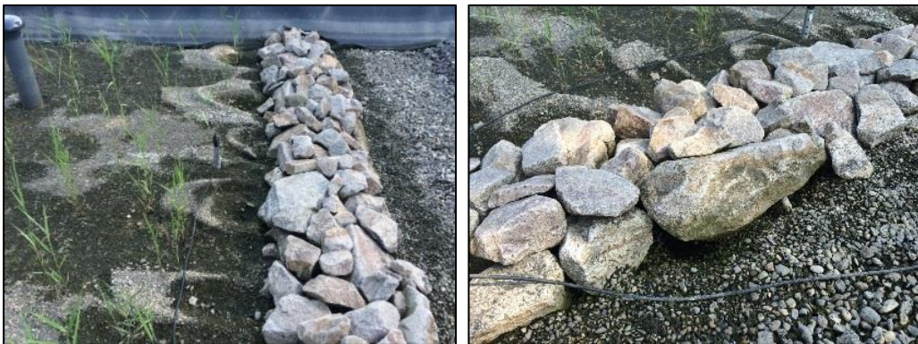
Figure 4-2 : Charriage du matériau filtrant lors des alimentations verticales (24/06/2016)
