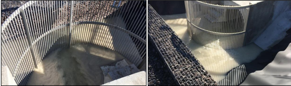
Figure 3-5 : Zone de dissipation du flux hydraulique (29/04/2016)
