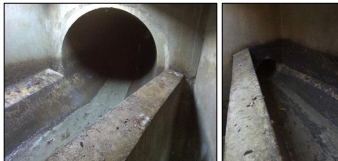
Figure 2-3 : Vues des conduites d'entrée \varnothing 1000 mm (gauche) et conservée \varnothing 300 mm (droite) du déversoir d'orage 8001 alimentant le filtre (15/02/2016)
