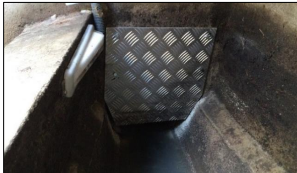
Figure 2-13 : Vannage de la conduite conservée du déversoir d'orage 8001 (31/03/2016)
