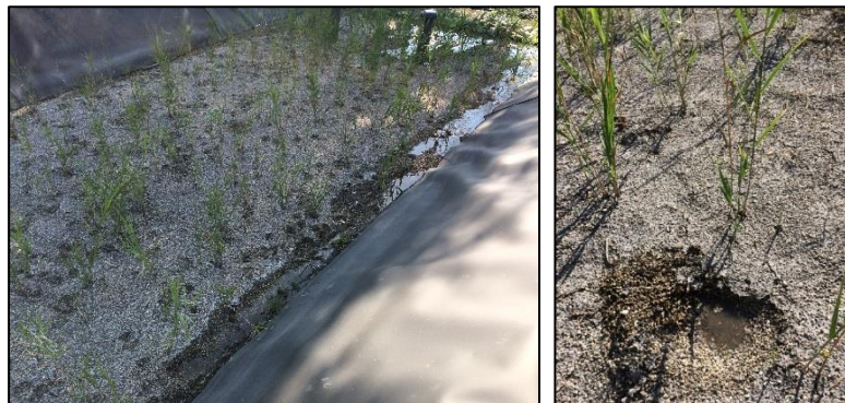
Inégale répartition en surface pour des alimentations horizontales avec présence de l'effluent 5 cm sous la surface du filtre (02/09/2016)
