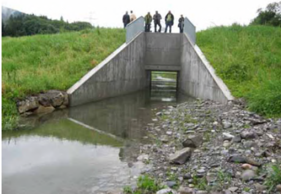
Fig. 33. Exemple d'ouvrage de ralentissement dynamique en Autriche
