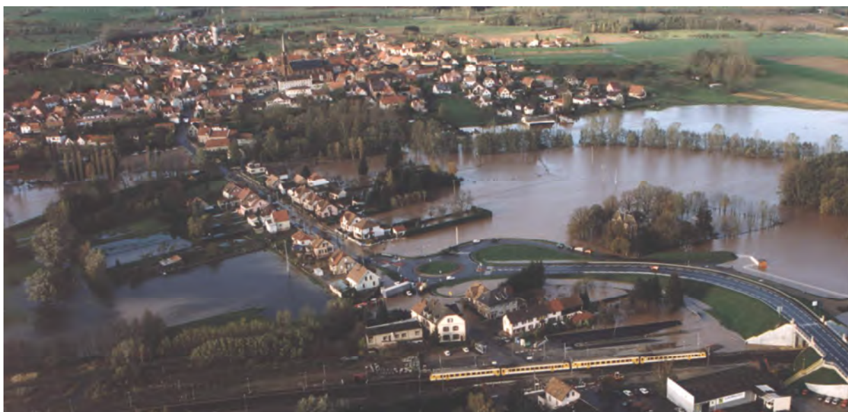
Fig. 29. Inondation de 1998 rue de la gare à Steinbourg, photo aérienne DDAF Saverne
