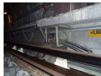
Figure 23: pénétration dans le sous-quai
