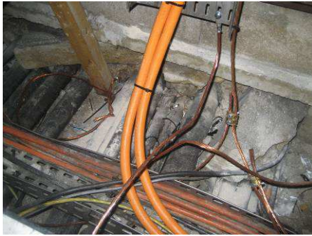
Figure 20: local onduleur ECS vers poste PEF
