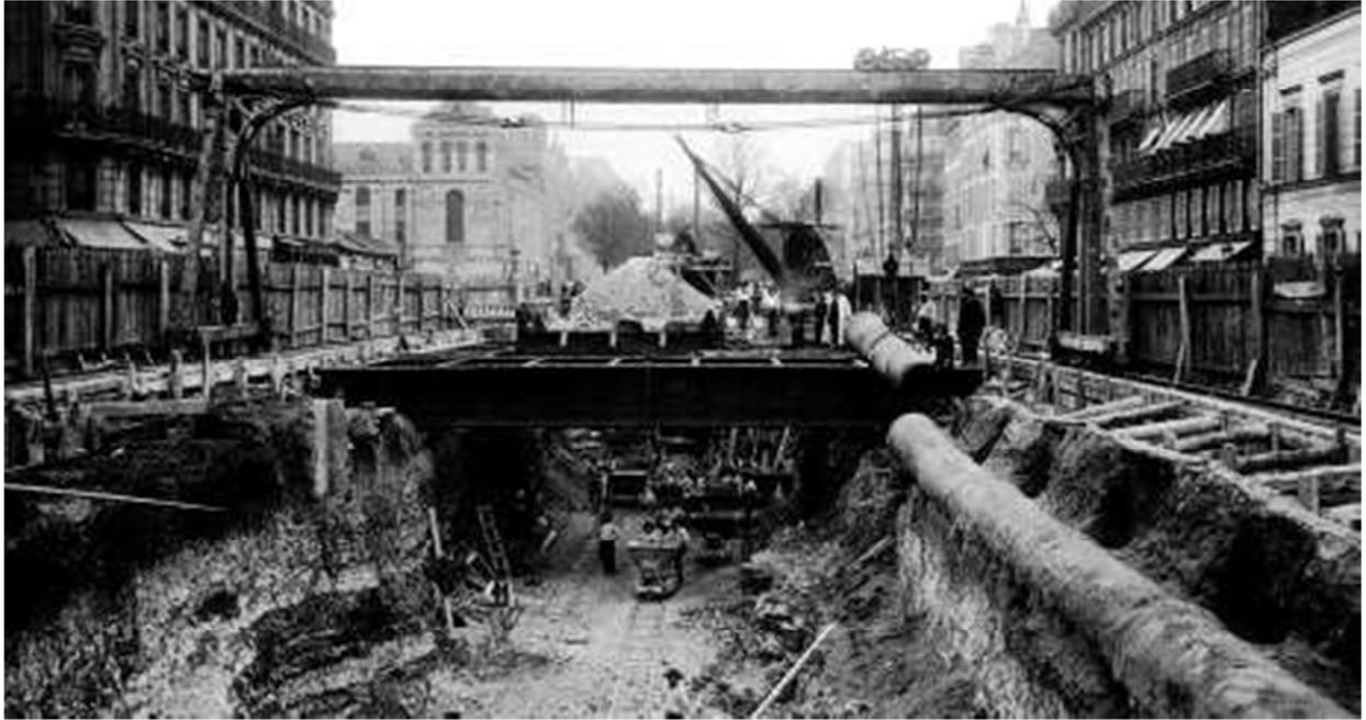
Figure 8. Tranché Rue de Rivoli Paris. Ici la réfection de la rue passe par l'ouverture de tranchées qui accueilleront les réseaux tels que l'eau, le gaz ou les égouts. Ce fut la source d'un grand progrès sanitaire pour la ville reprenant l'idée de la Maxima Cloaca de Rome. Source [www.cultivoo.com](http://www.cultivoo.com)
