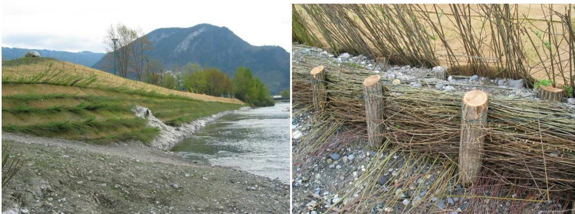
**Figure 8 : Exemples d'aménagements en génie végétal a) Tenue de berge par la végétation sur fibre de coco b) Fascines de saules (Source : Frossard, 2009)**
