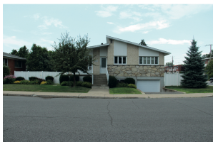
Vue de la maison unifamiliale de face
