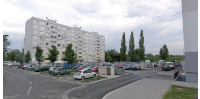
Stationnement en coeur d'îlot (avant)
