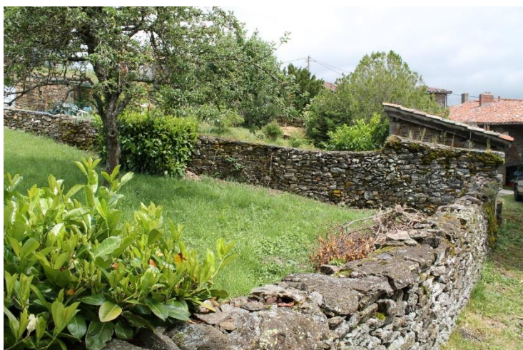
Figure 30 : Muret de clôture. Photo : B.R.
