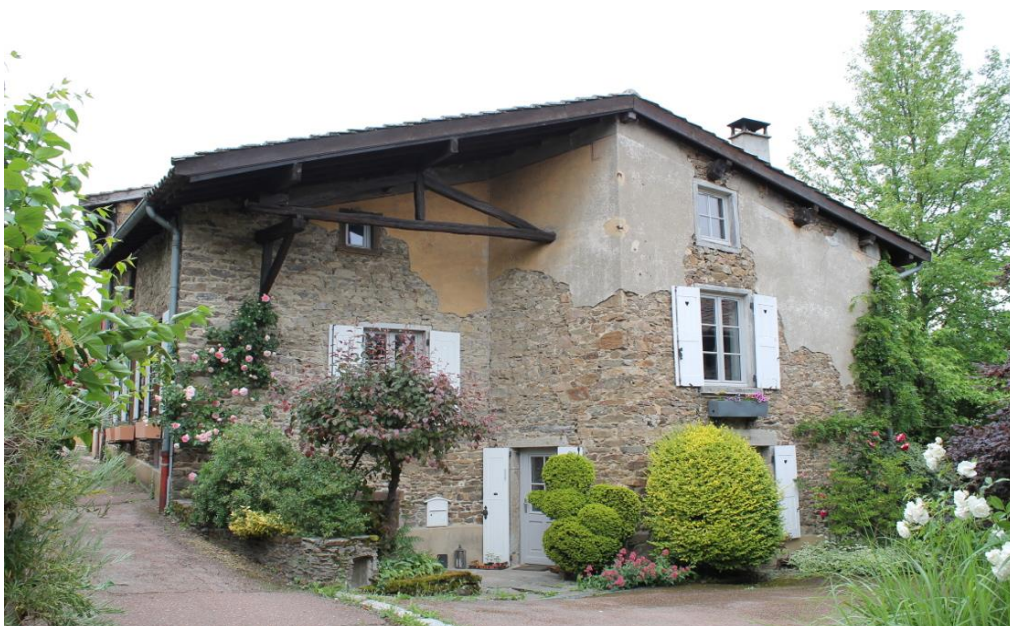
Figure 16 : Exemple de façade où l'ancien enduit est encore partiellement visible. Photo : B.R.
