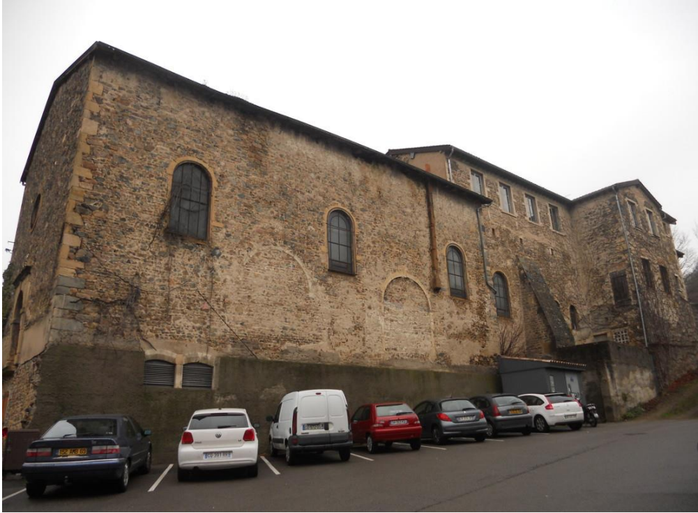
Figure 49 : Parking accolé à la chapelle du Prince Picpus. Photo : B.R.
