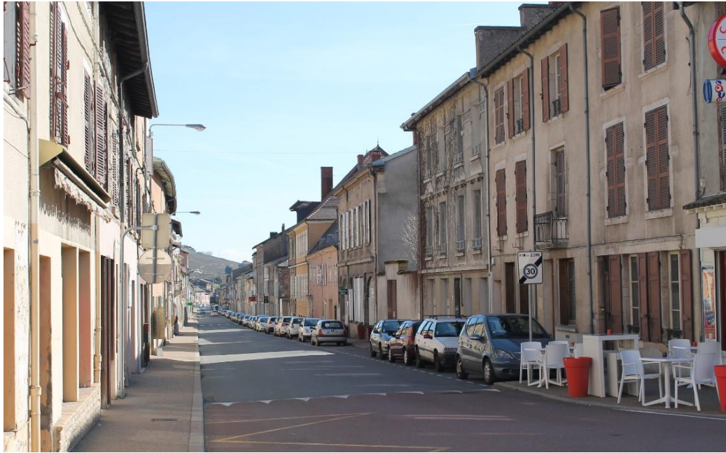
Figure 47 : Beaujeu, front bâti rectiligne vers l'est. Photo : B.R.
