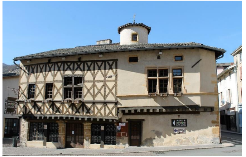
Figure 55 : Maison à pans de bois. Photo : B.R.
