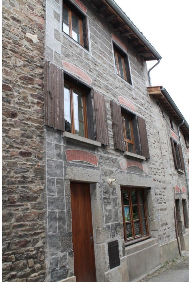
Figure 17 : Exemple de façade traitée avec un enduit en joints rubanés. Photo : B.R.
