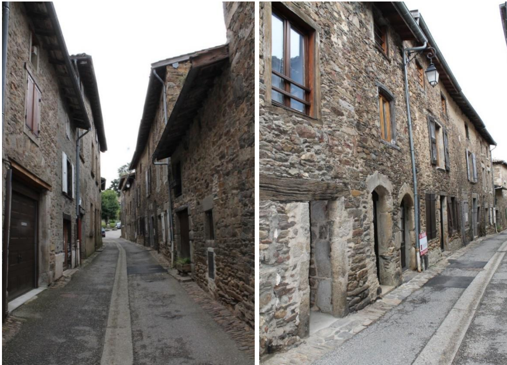
Figure 14 : Exemples de maisons de bourg à Riverie. Photos : B.R.
