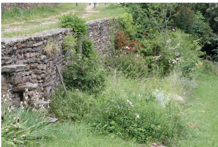
Figure 30 : Muret de soutènement. Photo : B.R.
