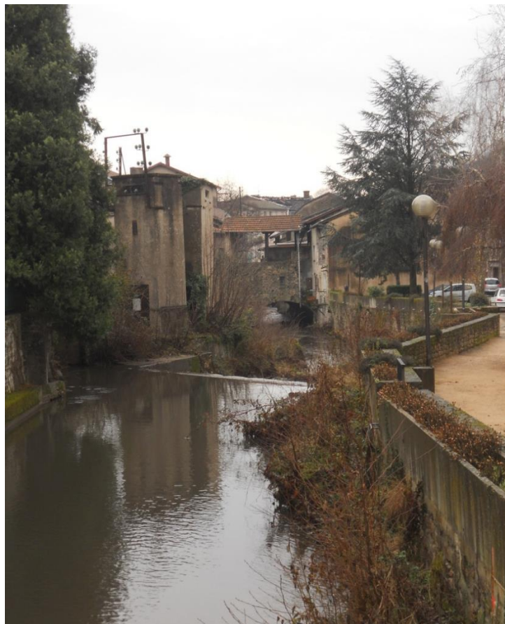
Figure 50 : Ouvrages hydrauliques au-dessus de l'Ardières. Photo : B.R.
