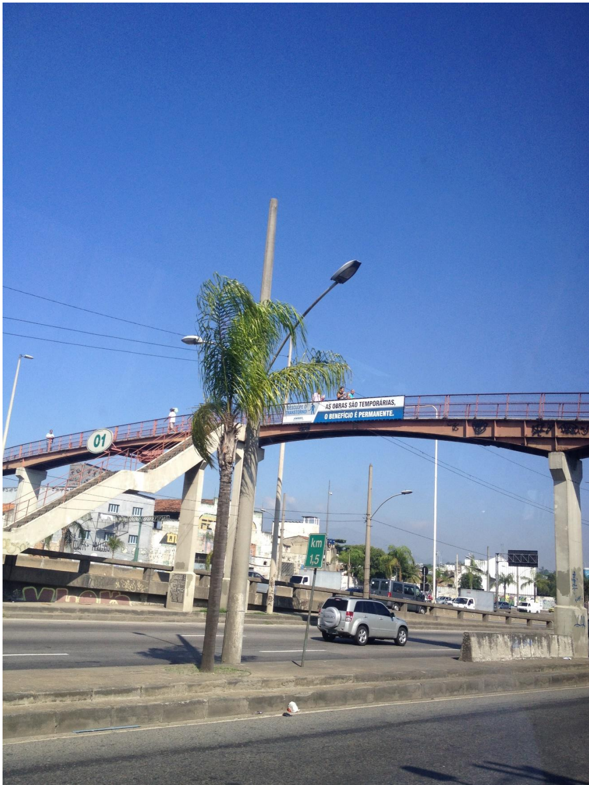
Passerelle n°1 de l'Avenida Brasil Sur le panneau de la préfecture on remarque l'inscription suivante : « Les œuvres sont temporaires, le bénéfice est permanent ».
