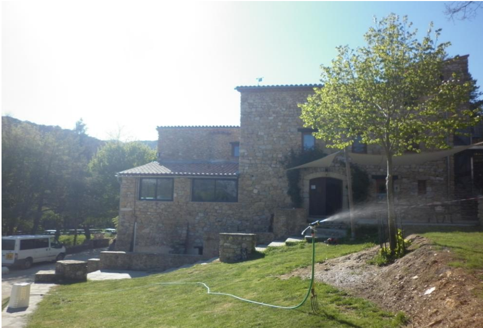
Bâtiment principal : lieu de vie et bureau de l'association du site de Rougon
