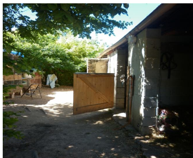
Boxes pour chevaux servant à ranger le matériel
