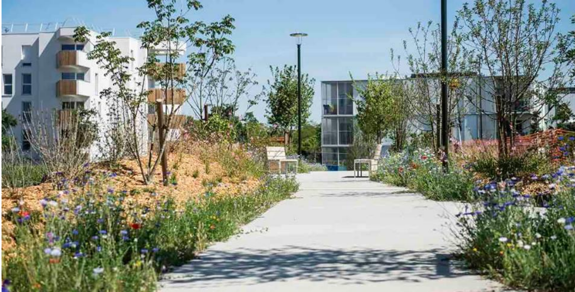
Figure 7. Photographie de la voirie en béton balayé du Parc habité des Sècheries (source : Agence Trouillot et Hermel, 2017)
