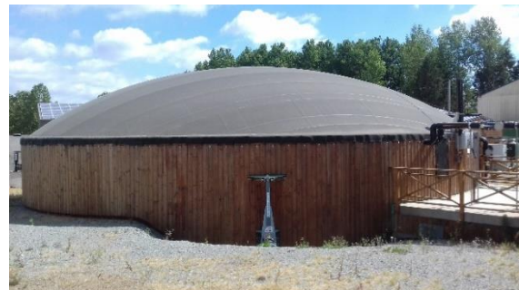
Figure 18 : Magny le Désert, Méthaniseur avec son toit bâché rempli de biogaz, 2017, Lecrosnier
