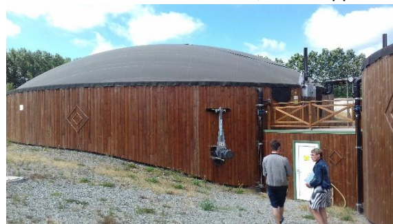
Figure 19 : Magny le Désert, connexion entre les deux méthaniseurs, 2017, Lecrosnier
