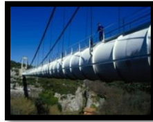
Figures 4 à 7 : Canal de Pourrières, prise de Boutre, Galerie du Luberon, aqueducs de Saint-Bachi
