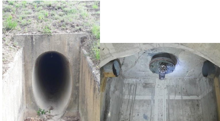
Figure 16, 17 : Ovoïde sous le canal, drains sous le canal
