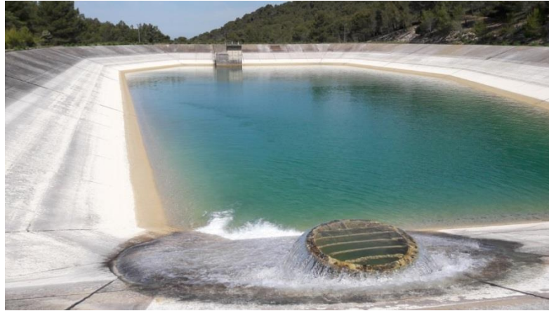
Figure 6 : Réserve de Chantperdrix sur Aix-en-Provence
