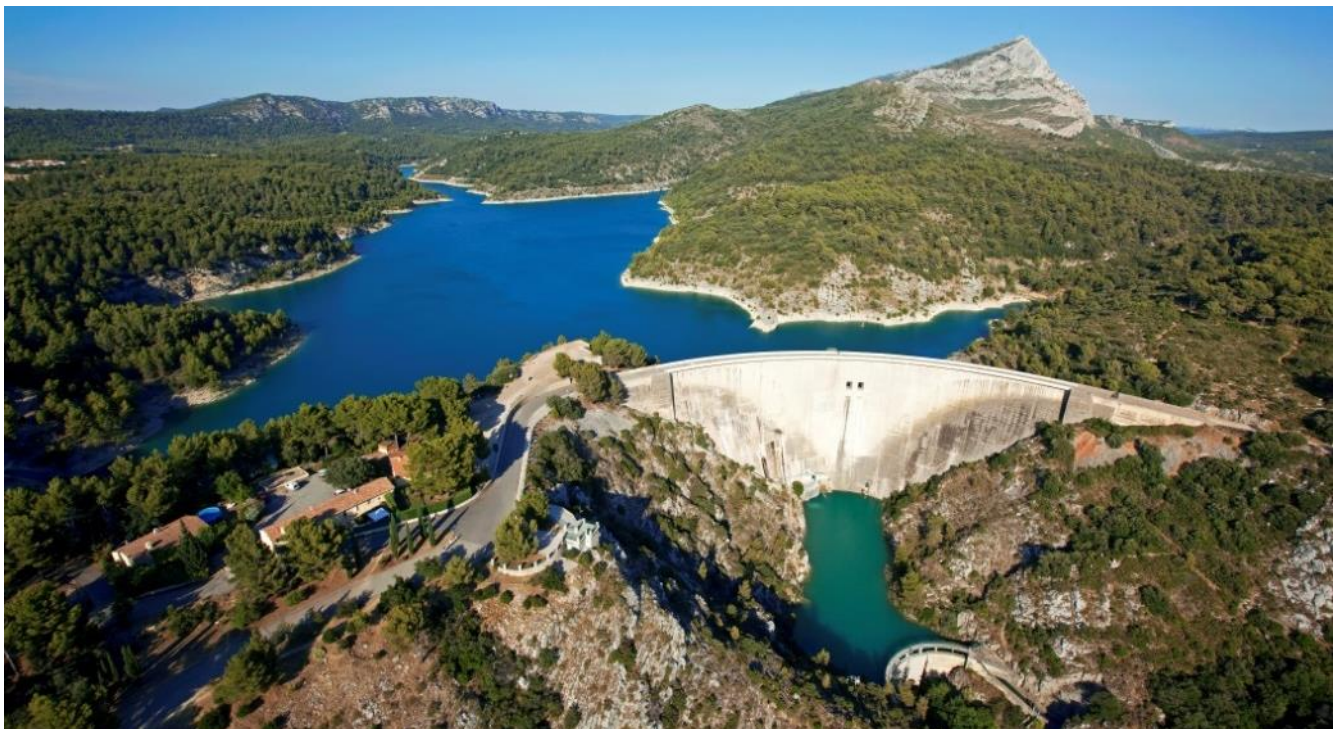
Figure 5 : Barrage de Bimont sur Aix-en-Provence
