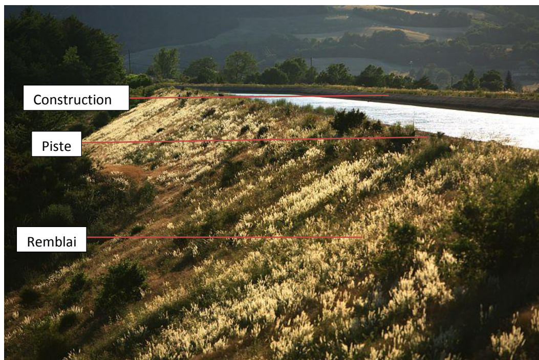
Figure 8 : Portion du canal de Ginasservis dans le Var, soutenu par un remblai en terre
