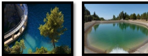
Figures 8 et 9 : Barrage de Bimont, réserve de la Barounette
