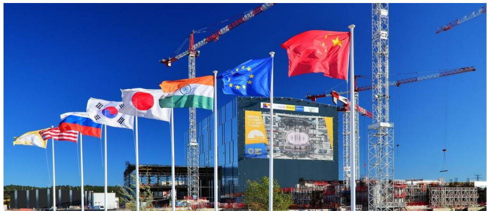
Figure II - État actuel du chantier
