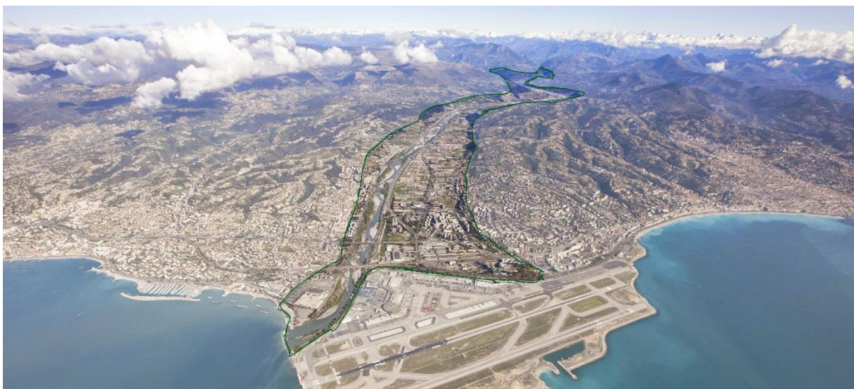
Figure 8 : Périmètre de l'Eco-Vallée et urbanisation au détriment des paysages naturels - 2016 (Photo : Franklin Azzi Architecture)
