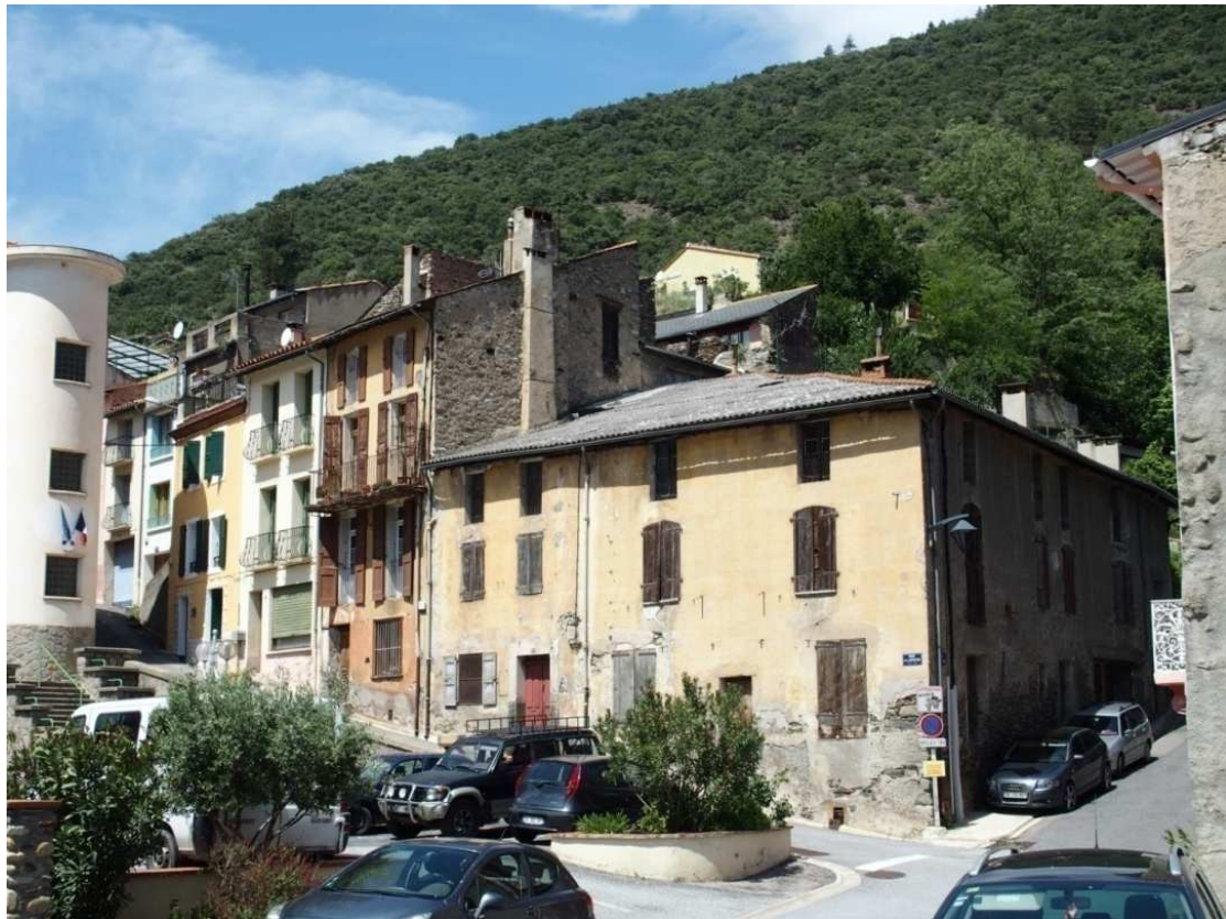
Fig. 17 : Un habitat délaissé qui se dégrade dans le centre-bourg d'Olette
