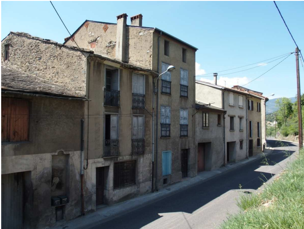
Fig. 40 : Habitat dégradé le long de la RN116, Serdinya
