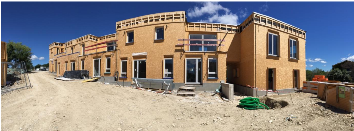
Figure 1 : Projet d'habitat participatif des Colibres en construction
