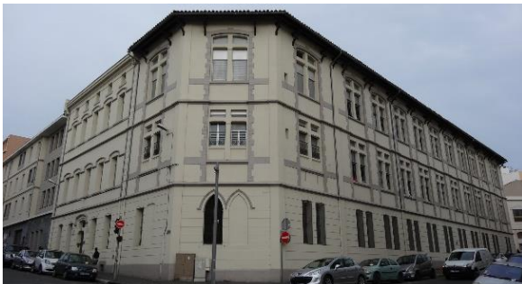
Fig. 34 : Façade extérieure du centre, à caractère historique
