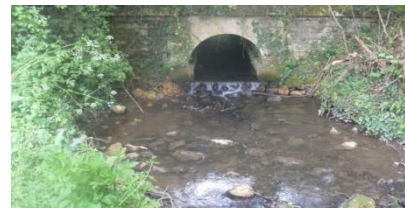
Figure 23 : Ouvrages piscicoles aménagés (SYRLA)
