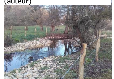
Figure 29 : Diversification des écoulements, radier (auteur)
