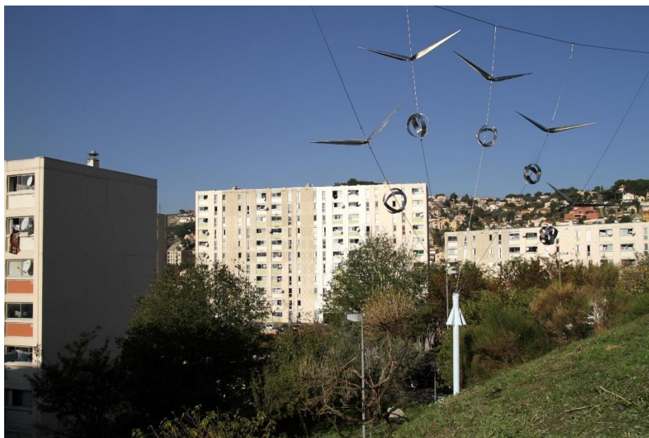
Figure 12: La Bricarde, Marseille Réalisation : LOGIREM, 2017
