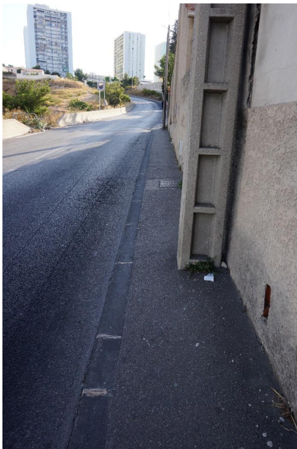
Figure 36 : Le chemin de la Bigotte, une circulation piétonne peu aisée Source : Photographie personnelle, août 2017
