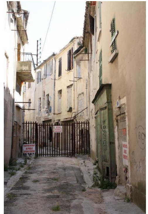
Figure 6 : Une ruelle du centre ancien de Marignane Source : ANRU.fr
