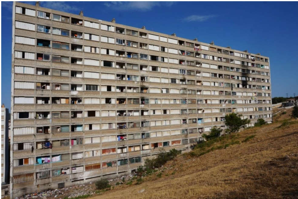
Figure 56 : Le bâtiment H se présente comme l'un des plus dégradés du Parc Kallisté
