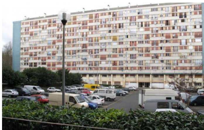
Figure 14 : Un immeuble dégradé de la copropriété du Chêne Pointu Source : Le Parisien
