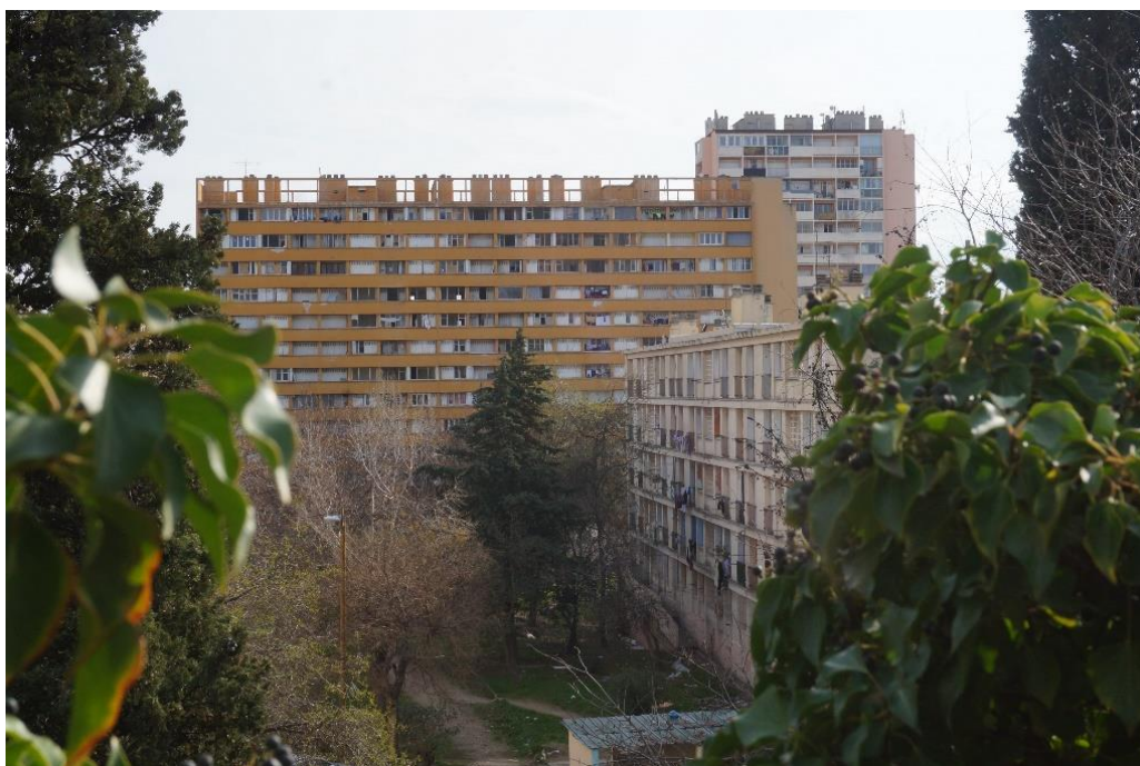
Figure 7 : La copropriété dégradée Corot dans le 13ème arrondissement de Marseille Source : Photographie personnelle, mars 2017
