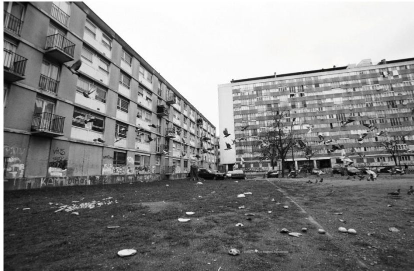
Figure 12 : La copropriété des Bosquets à Montfermeil et Clichy-sous-Bois (93) Source : L'erreur est urbaine
