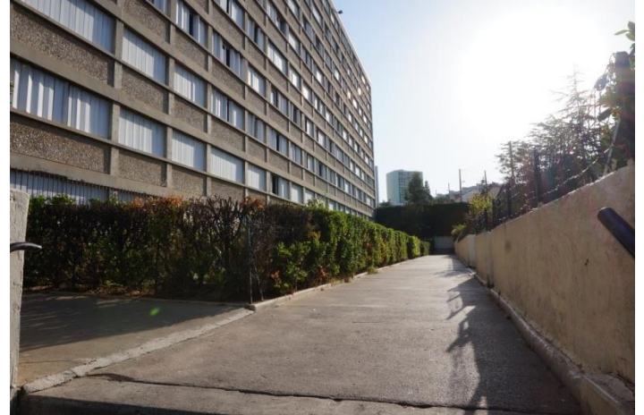
Figure 54 : Des haies taillées et entretenues au pied du bâtiment F Source : Photographie personnelle, août 2017
