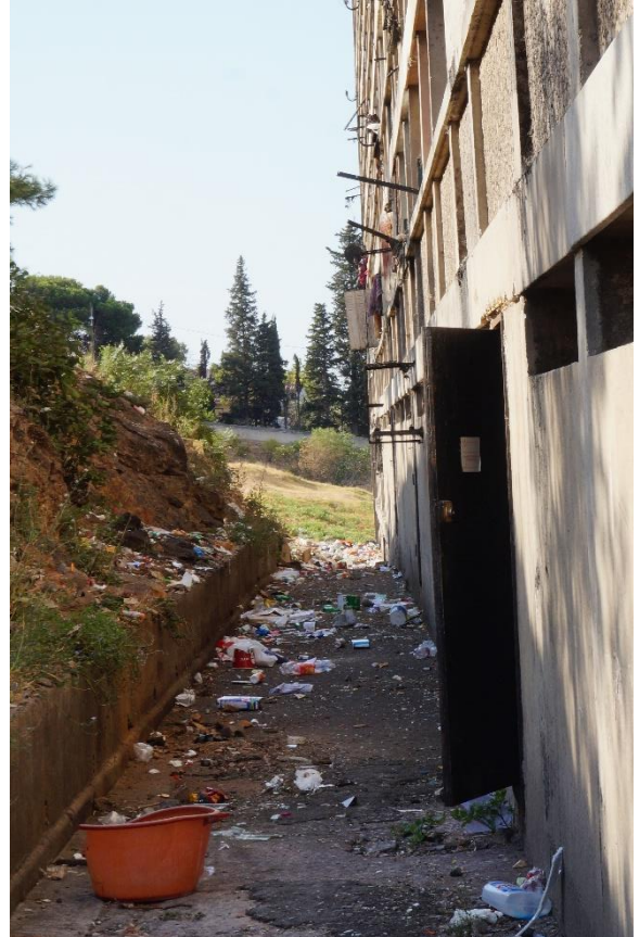
Figure 43 : L'arrière d'un bâtiment jonché de déchets ménagers Source : Photographie personnelle, août 2017
