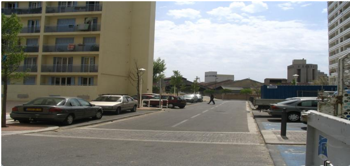
Figure 16 : Percée créée suite aux démolitions du bâtiment A Source : Ville de Marseille
