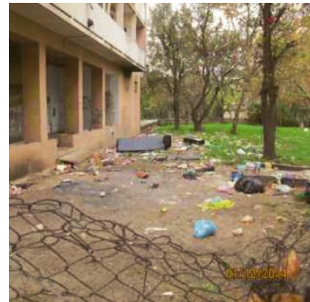
Figure 11 : Des espaces extérieurs jonchés d'ordures à l'arrière d'un immeuble Source : Rapport Urbanis sur le Parc Corot, juin 2015
