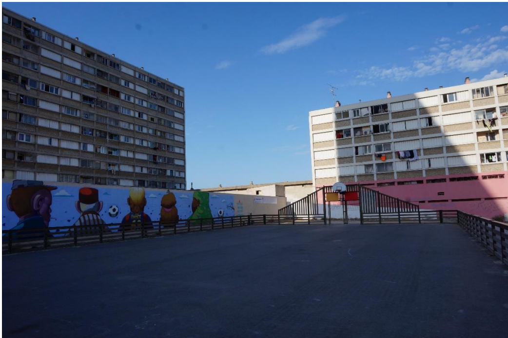
Figure 40 : Le terrain du polysport, en attente de rénovation Source : Photographie personnelle, août 2017
