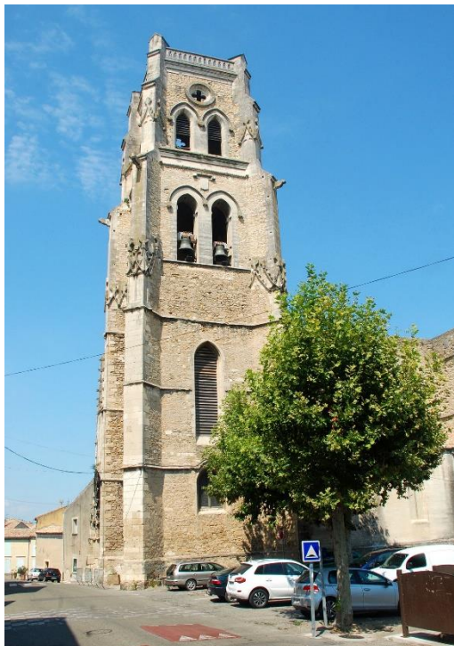
Figure 33 : Eglise Saint-Saturnin à Pont-Saint-Espirit (30)
