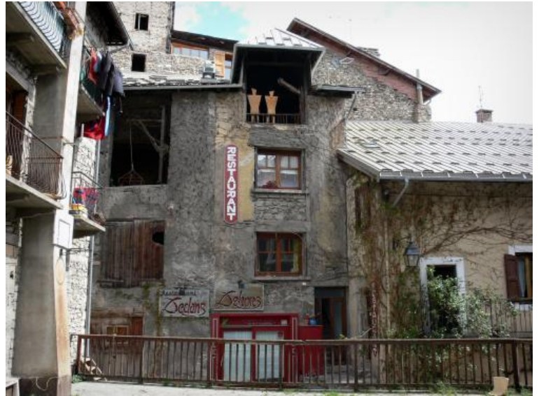
Figure 14: Bâtiments du centre historique de Guillestre datant du XVe siècle
