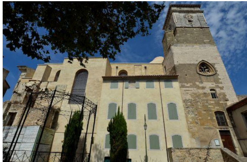
Figure 35: La réhabilitation du prieuré Saint-Pierre à Pont-Saint-Esprit (30)
