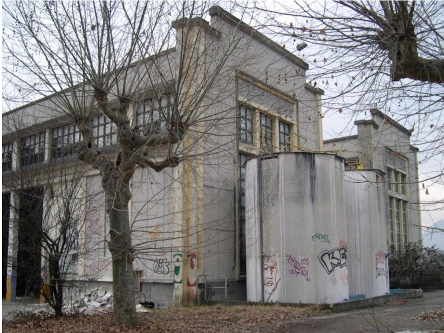
Photo 2 : Le bâtiment des Papeteries avant sa réhabilitation
