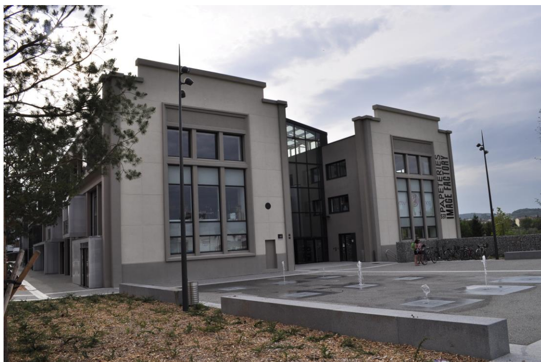
Photo 3 : Le bâtiment des « Papeteries Image Factory » réhabilité
