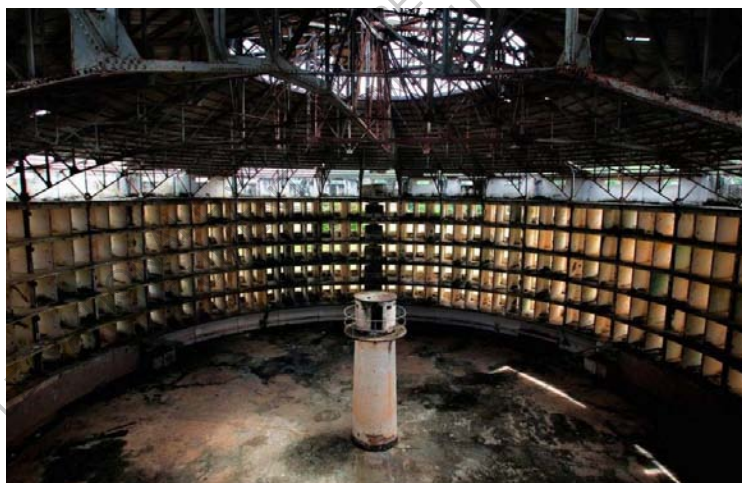
fig. 27 : Intérieur de la prison Presidio Modelo, à Cuba, construite sur le modèle du panoptique, fermée en 1967. [ http://www.laboiteverte.fr/presidio-modelo-prison-cubaine-panoptique/ ].
