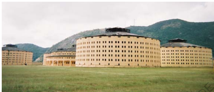
fig. 26 : Extérieur de la prison Presidio Modelo, à Cuba, construite sur le modèle du panoptique, fermée en 1967. [ http://www.laboiteverte.fr/presidio-modelo-prison-cubaine-panoptique/ ].
