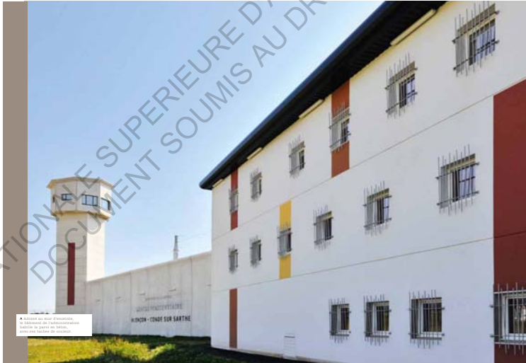
fig. 34 : Photographie d'une façade du centre pénitentiaire de Condé-sur-Sarthe où on discerne le même barreaudage, issue de la plaquette de l'APIJ sur cette prison. (JUSTICE, 2017c).
