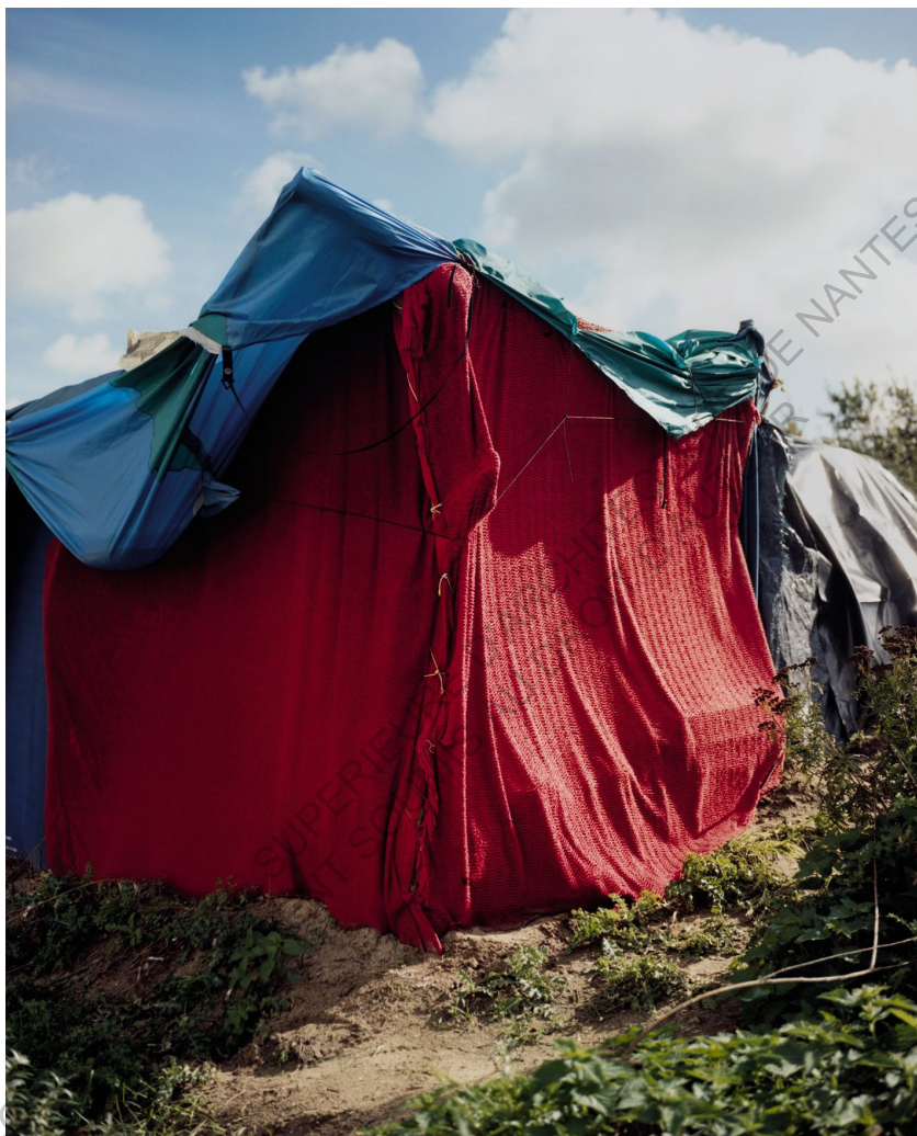
Bâche d'étanchéité, drap d'isolation et ficelle de fixation : Dispositif hors d'eau et d'air.
