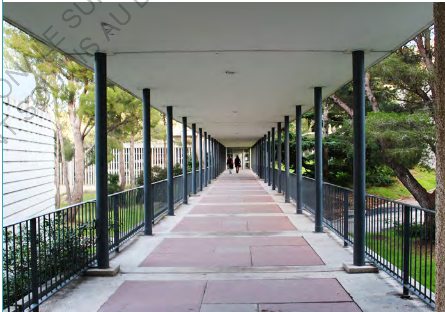
► Passerelle reliant l'école des Beaux-Arts à l'école d'architecture
