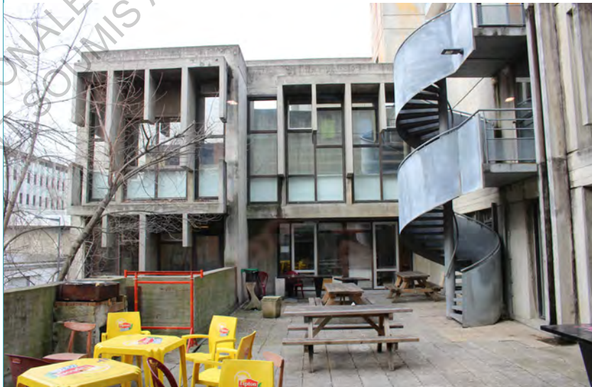
► Vue d'une terrasse, coté Sud.
