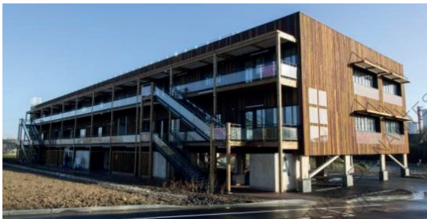
Figure 3 : premier bâtiment labellisé biosourcé au Havre
