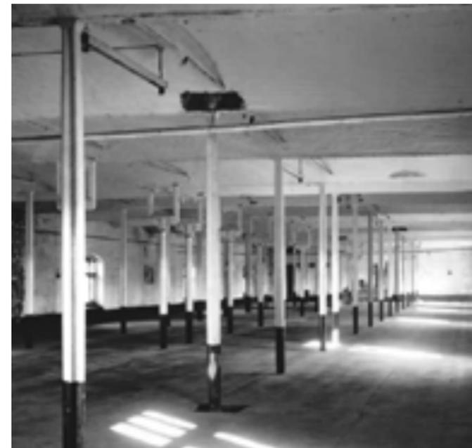
**7.** Au début du XIXe siècle, les usines anglaises sont les plus avancées. Le plan libre préfigure l'usine de toujours. Watt et Bulton reprendront le modèle pour le perfectionner. Des colonnes creuses, remplies d'eau ramènent le premier chauffage central.
