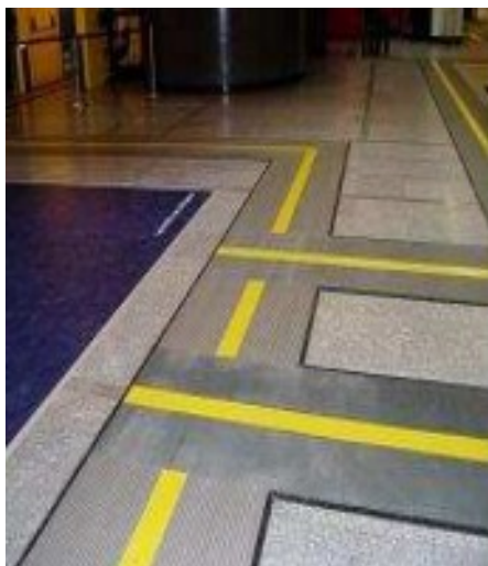
Exemple de bande de circulation (21)
