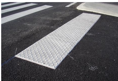
Bande d'éveil vigilance disposée avant la traversée de la voie véhiculé
