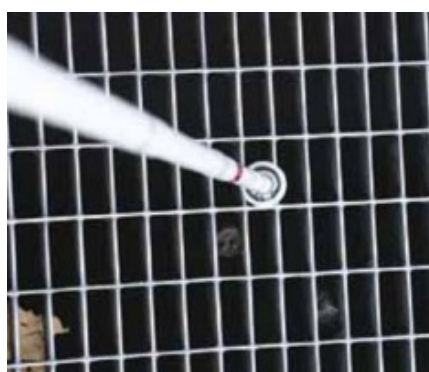
Exemple d'une grille d'évacuation
