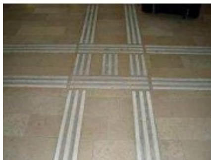
Exemple de bande de guidage à 3 cannelures sans semelle (21)
