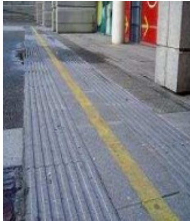
Exemple de bande de guidage sous forme d'engravures (21)
