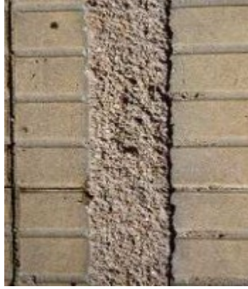
Exemple de bande de guidage d'enrobé gravillonné (21)
