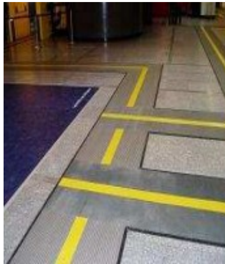
Exemple de bande de circulation (21)
