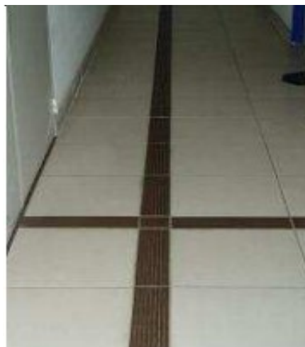
Exemple de carrelage de guidage (21)
