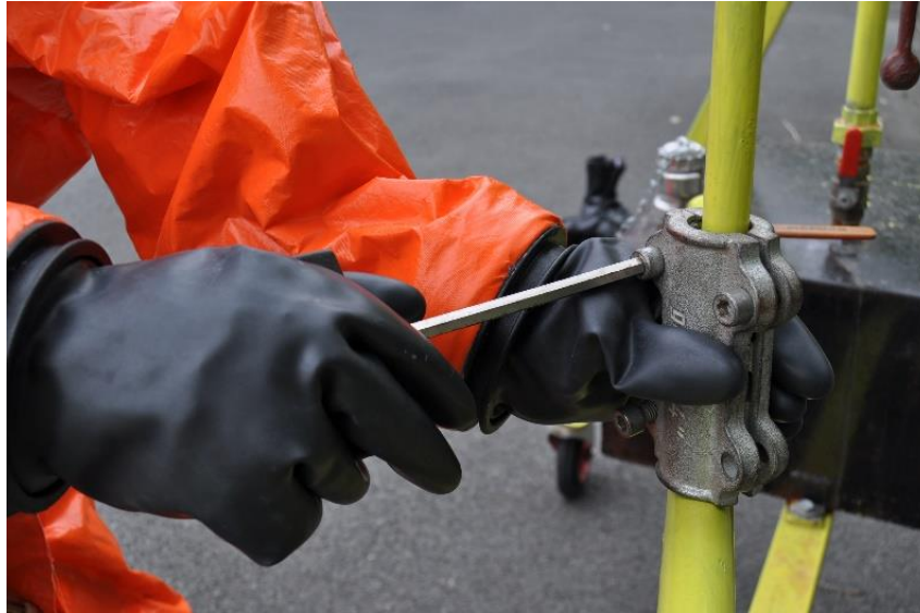
Figure 14 : Pose d'une bride
