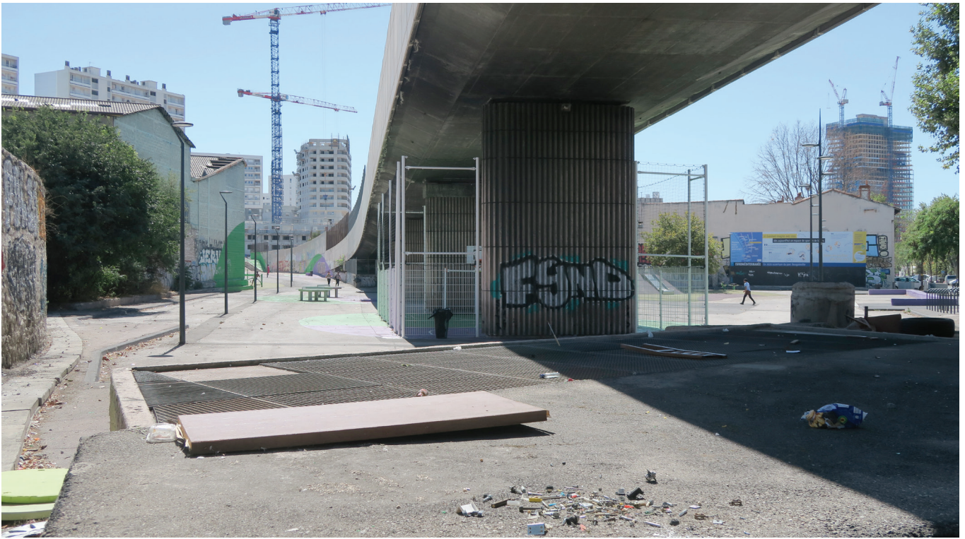
L'aire de jeux de Bougainville, avec, en arrière-plan, la tour « La Marseillaise », dessinée par Jean Nouvel et les travaux d'extension d'Euroméditerranée.
