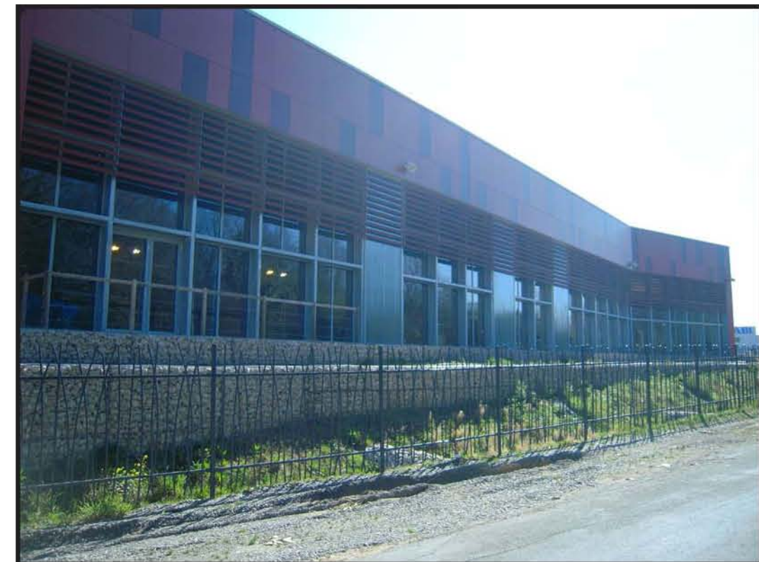
Vue depuis la route à l'Ouest vers le bassin sportif
