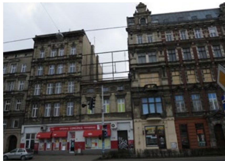
Façades du quartier du «Triangle des Bermudes» - photo personnelle
