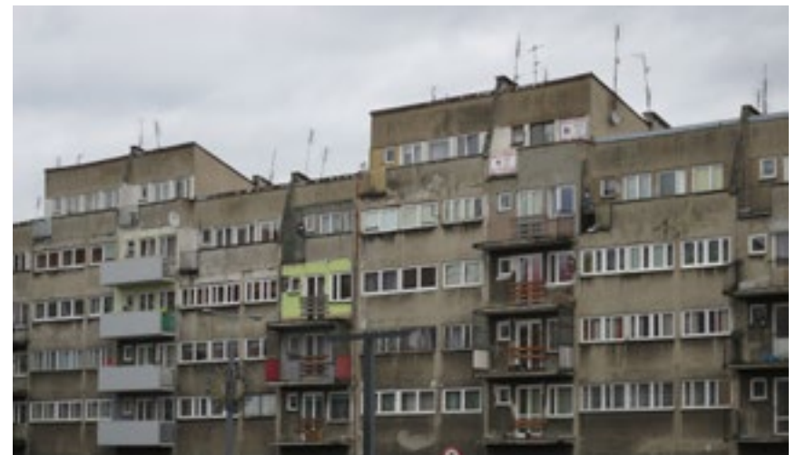
Façades près de la place Nowy Targ - 2015 - photo personnelle
