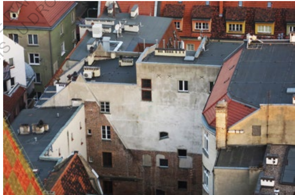
Décrochés d'immeubles dans le centre ville de Wrocław - photo personnelle
