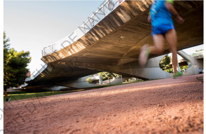
Photo - revêtement spécifique tout le long du circuit http://www.valenciaciudaddelrunning.com/ciudad/circuit-5k/
