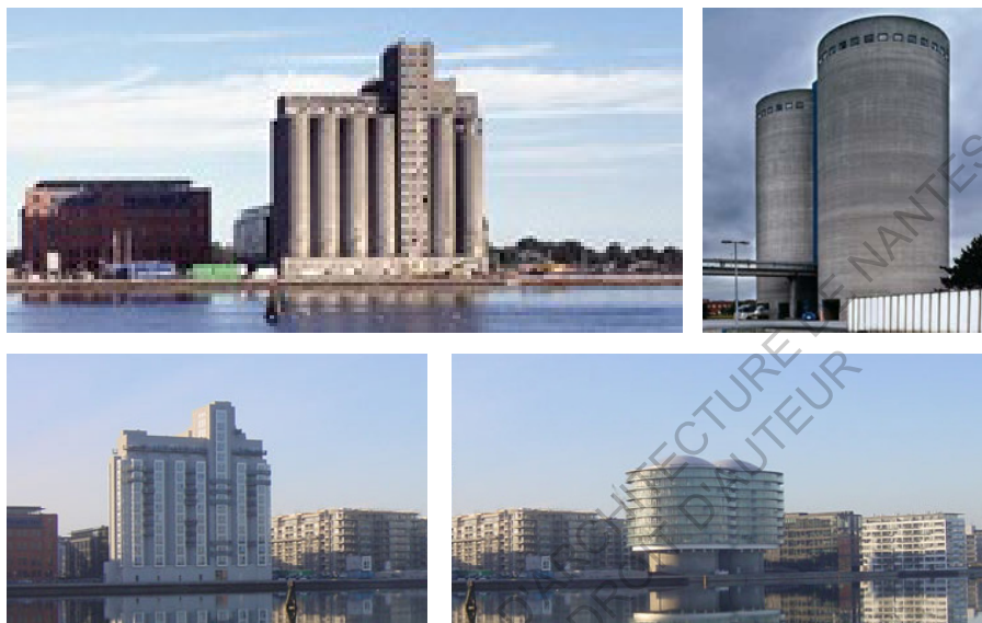
Fig. 77 Les silos Wennberg (à gauche) et Frosilo Gemini (à droite) avant et après reconversion.
