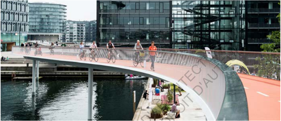
Fig. 25 «The bicycle snake», une passerelle cyclable traversant le port.
