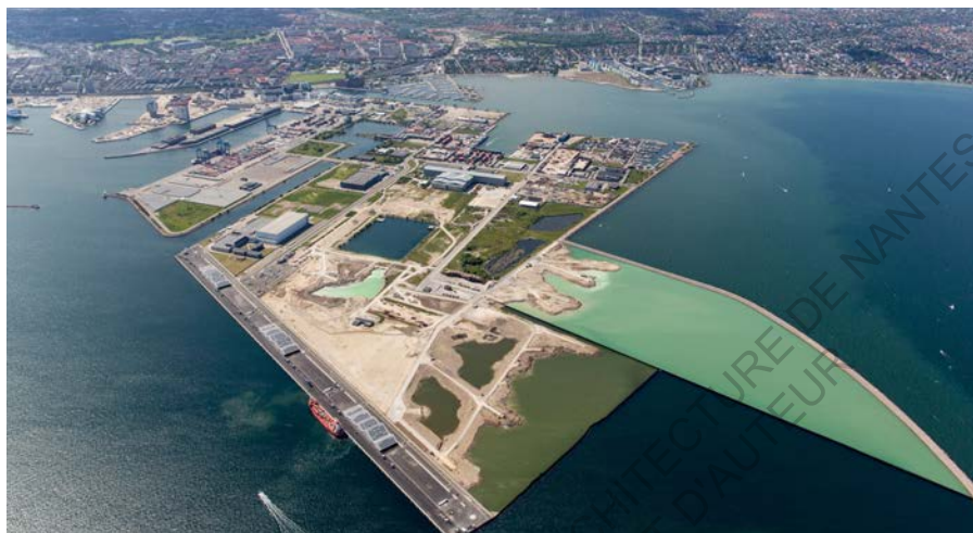
Fig. 37 Vue aérienne de Nordhavn.
