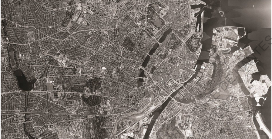
Fig. 10 Vue aérienne de Copenhague.
