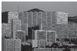
Fig 19 : Le quartier de La Rouvière à Marseille construit dans les années 70 par Xavier Arsène-Henry
