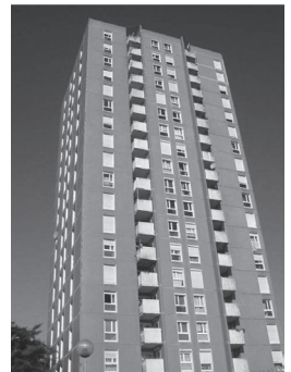
Fig 65 : tour de Malakoff avant réhabilitation
