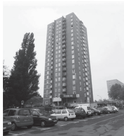
Fig 82 : tour avant réhabilitation
