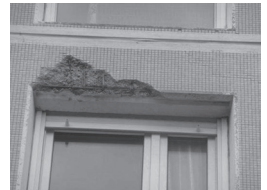
Fig 63 : éclats repérés sur les panneaux préfabriqués
