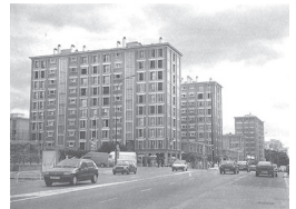
Fig 36 : quartier de l'église à Pantin, Seine-Saint-Denis
