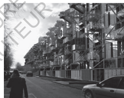
Fig 12 : Barre Euclide à Tourcoing, Atelier Gens Nouveles architectes
