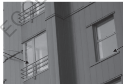
Fig 84 : Bardage métallique en façade et loggias fermées
